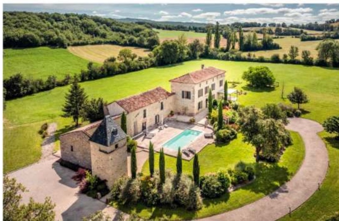
Cet ensemble quercynois des 17ème et 19ème siècles dans son environnement paysager a fait l'objet d'une belle rénovation. © Groupe Patrice Besse
