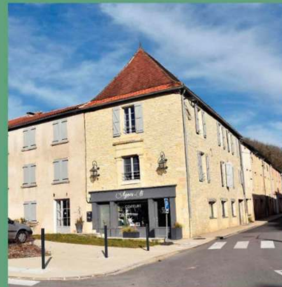
Dans le cadre de l'OPAH-RU multisites Cœurs de bourgs du Grand Cahors, la réhabilitation à Catus d'une importante bâtisse par ses nouveaux propriétaires a permis de créer deux logements et l'ouverture d'un commerce en plein centre de la commune. © Christine Hoden
