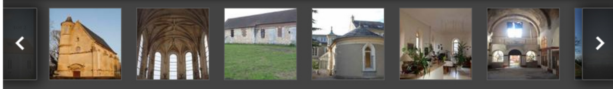
Ce prieuré des 12e, 13e et 17e siècles installé à une heure de Rodez et Cahors est inscrit aux monuments historiques. Le bâtiment principal couvre pas moins de 1060 m 2 . L'ensemble est proposé à 830.000 euros. Crédits photo : Patrice Besse
