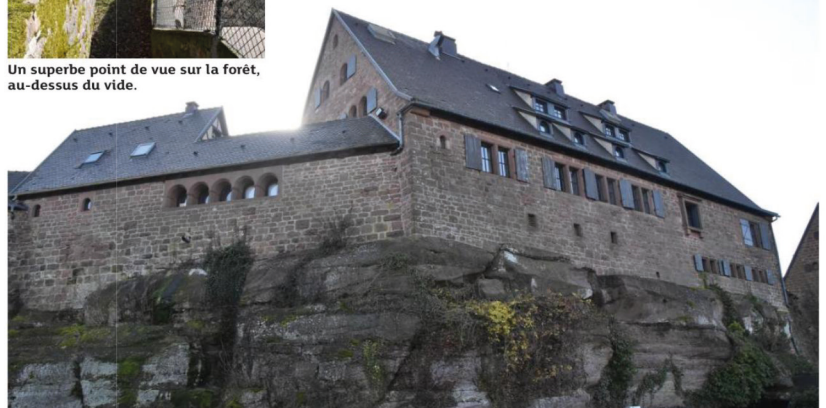
Les remparts suivent la barrière de grès, à plus de 415 mètres d'altitude. PHOTOS DNA - EMMANUEL VIAU
